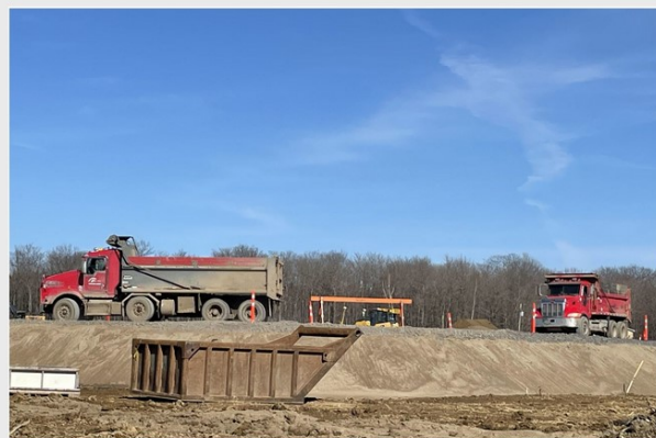
Les camions se succèdent sur le chantier pour y déverser leur contenu. (Photo : Pierre Paquet)
