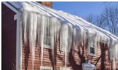
Ce barrage de glace, qui apparaît aux extrémités du toit, empêche l'eau de s'écouler. Pendant les épisodes de redoux, il risque de provoquer des infiltrations d'eau et, du coup, des dégâts dans la maison.
